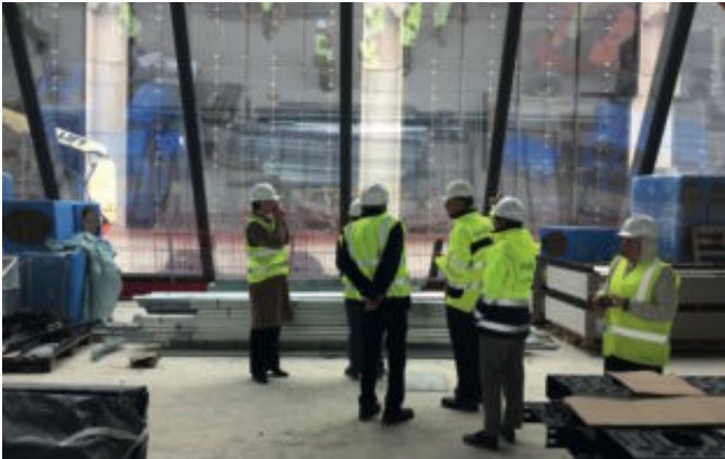
Un chantier complexe
