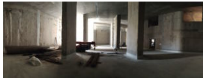
Partie de l'ouvrage du bassin de rétention © RC Ingénierie SA
