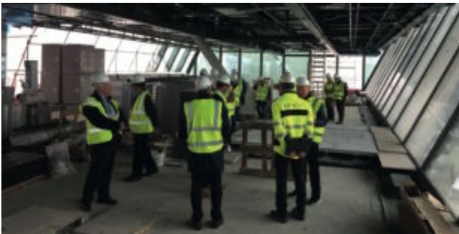
La visite du chantier de l'Aile Est
